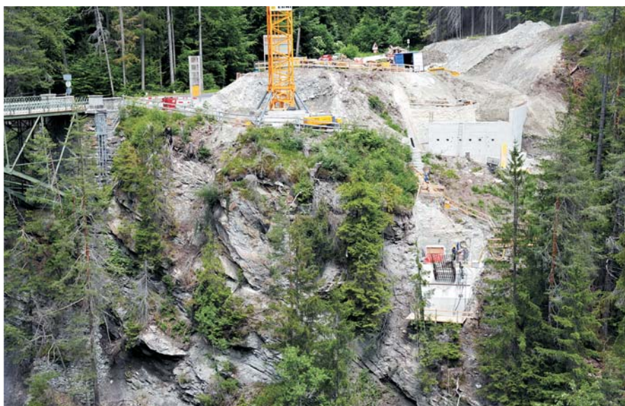
Bau des Widerlagers und des Stützenfundamentes in der Felswand Seite Bonaduz
