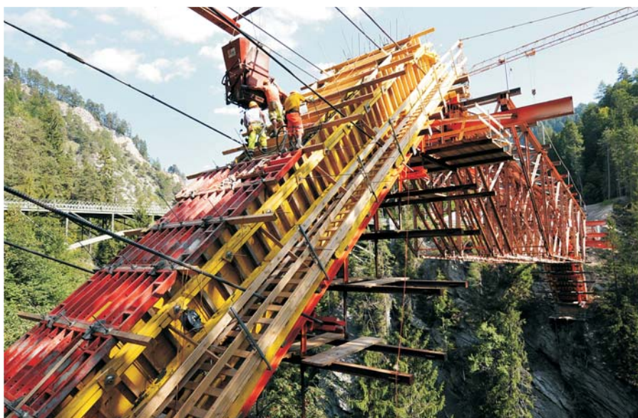
Betonieren der Stütze auf Seite Versam
