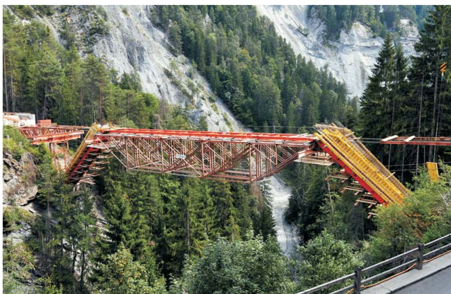
Lehrgerüst mit Schalung und Armierung der Stützen
