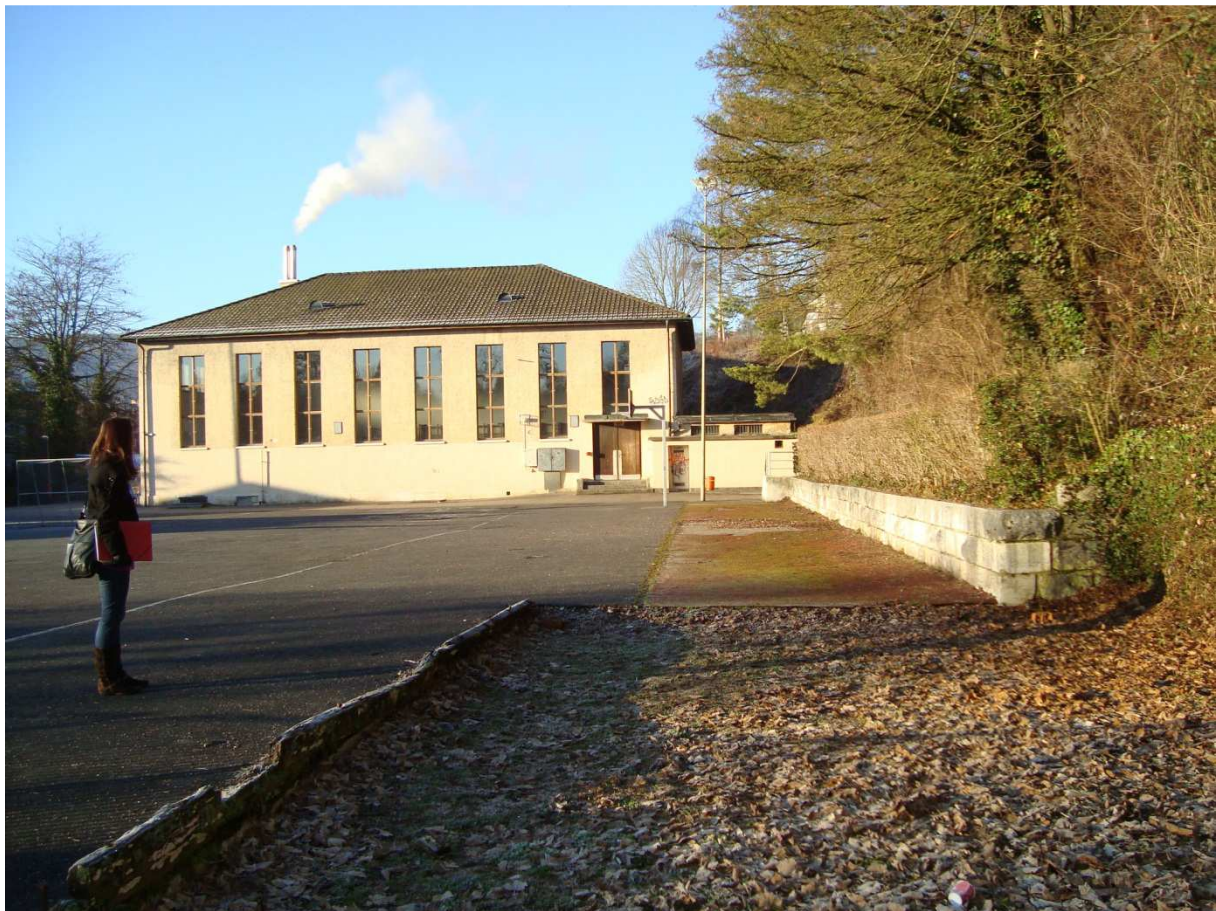
Bild 1: Blick vom Pausen- und Sportplatz Richtung bestehende Turnhalle
