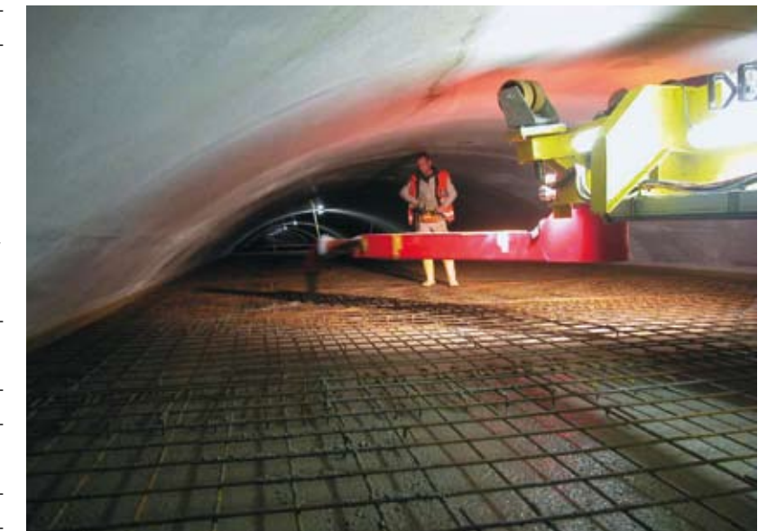
11 | Betonieren der Zwischendecke. Concreting the intermediate floor.
