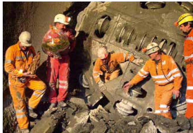
4 TBM-Durchschlag Sicherheitsstollen vom 20.11.2003 4 TBM breakthrough for safety tunnel in 20.11.2003
