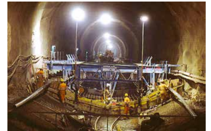
6 Sohlgewölbeschalung 6 Formwork for invert
