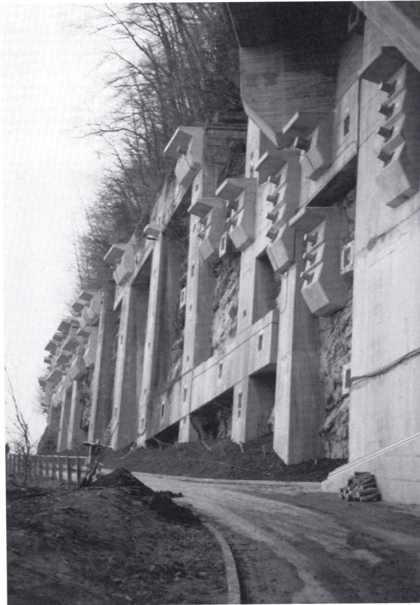
Teilansicht der instandgesetzten und verstärkten Felssicherung View of the repaired and reinforced anchored rock cut
