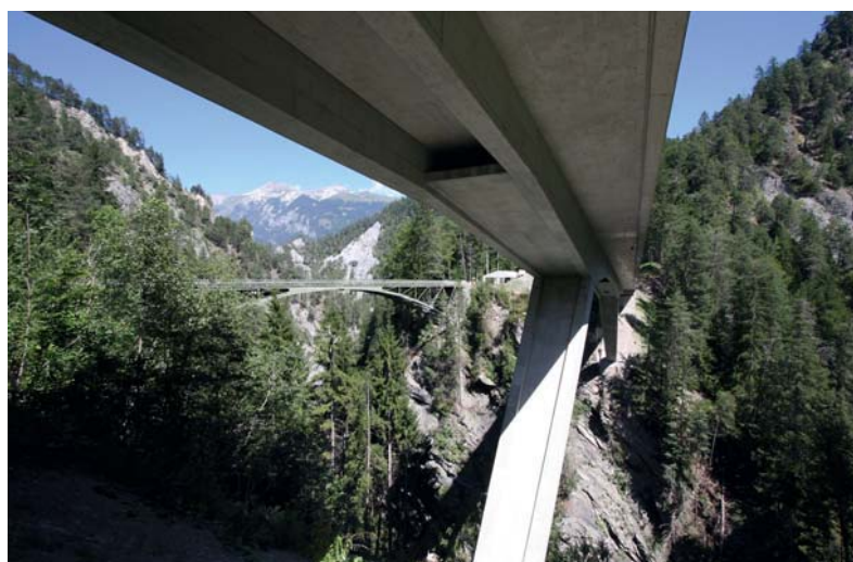
Fig. 2 Untersicht der Brücke mit Übergang vom offenen Plattenbalken zu Hohlkasten. View from below the bridge with transition of T-beam section to box girder.
