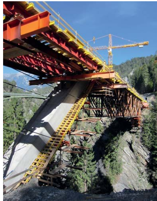
Fig. 7 Lehrgerüststiele mit Zugstangen zurückgebunden. Falsework with tie-back rods.
