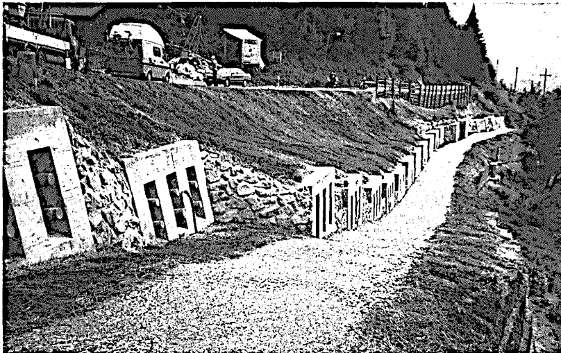
3: Verankerte Schubdübelpfahlwand Arschella Ost mit Zufahrt für den Unterhalt. Oben im Bild Oberalpstrasse.
