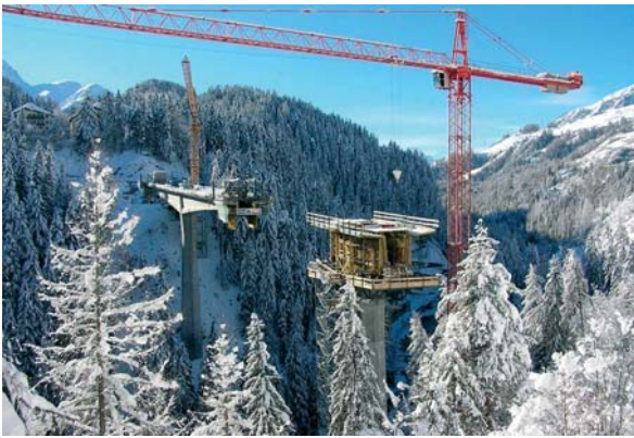
Fig. 3 Winterpause auf der Baustelle im Engadin. Winter break at the construction site in the Engadin.
