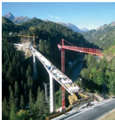
Fig. 9 Erstellung der Randfelder. Construction of the closure spans.
