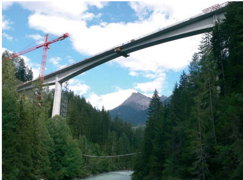
Fig. 6 Fugenschluss im Mittelfeld. Closure pour at midspan.
