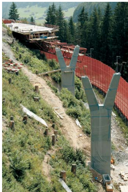
Die charakteristischen Ypsilon-Pfeiler, eingepackt zum Schutz gegen Verschmutzung.
