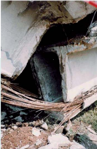
Eingestürzter Längsträger der Brücke San Stefano, Sizilien [13] Failed longitudinal girder of the San Stefano Bridge, Sicily [13]
