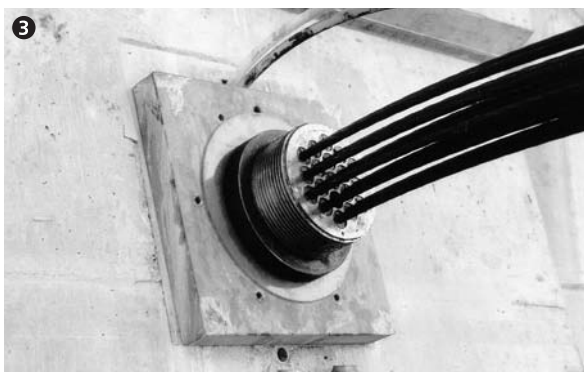
Der erste vollständig elektrisch isolierte Anker, auf 1965 kN gespannt, (1992). The first completely electrically isolated anchor, locked-off at 1965 kN (1992).
