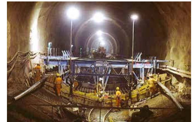
6 Sohlgewölbeschalung 6 Formwork for invert
