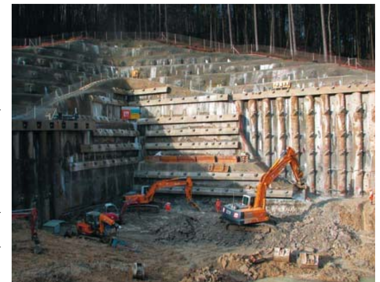
Voreinschnitt Nord. Approach cutting north.
