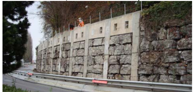
Bauwerk nach Instandsetzung.
