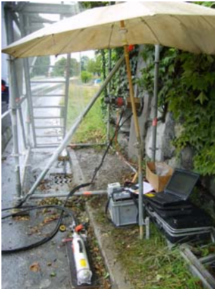
Prüfung der Anker im Strassenbereich.
