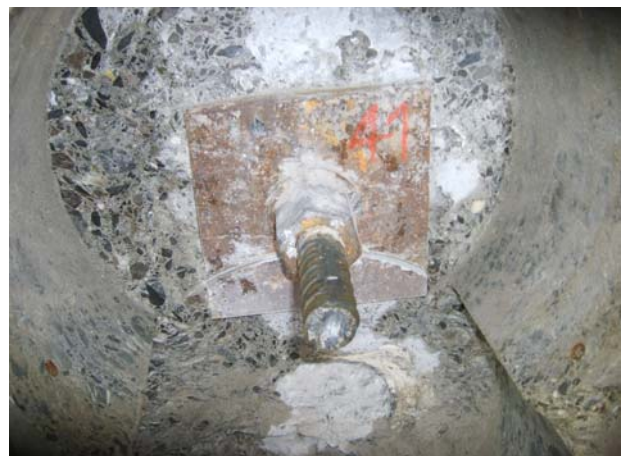
Bild 7 K2b LU, Verankerter Stützkörper Riedsort
