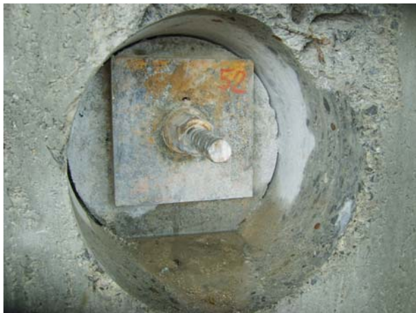
Bild 1 K2b LU, Verankerter Stützkörper Riedsort
