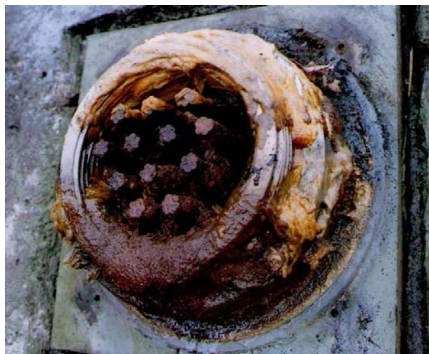
Bild 17 N08 OW, Stützwand Oberes Delli
