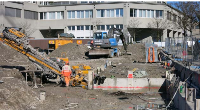
Ankererstellung für Rühlwand (1. Ausfachungsetappe)
