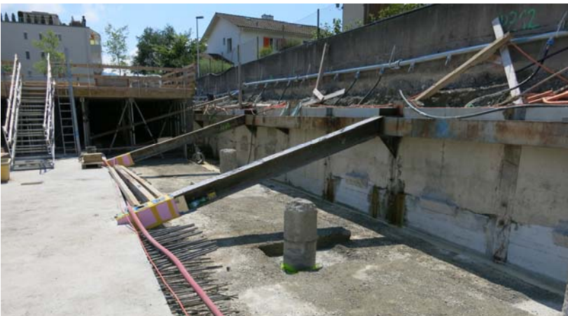
Gespriesste Rühlwand mit Schrägsprissen auf Bodenplatte
