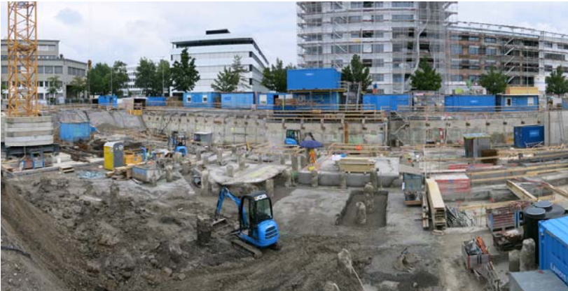
Baugrube mit Fundationspfählen und Ansicht an verankerte Rühlwand
