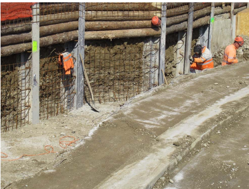
Ausfachung Rühlwand gegen SZU-Gleise mit Holz und Beton.
