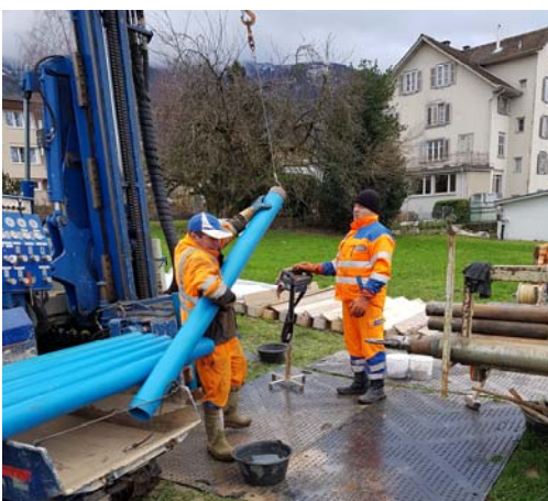
Einbau der Piezometerrohre ins Bohrloch.
