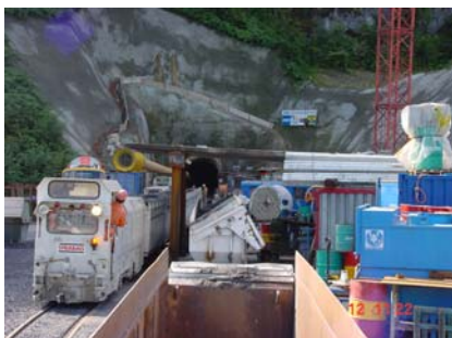
Materialumschlag mit Gleisbetrieb
