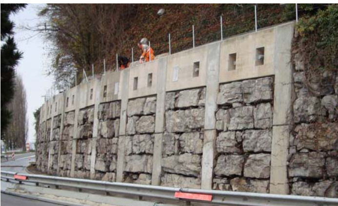
Stützkörper Riedsort nach den Verstärkungsarbeiten, 2010
