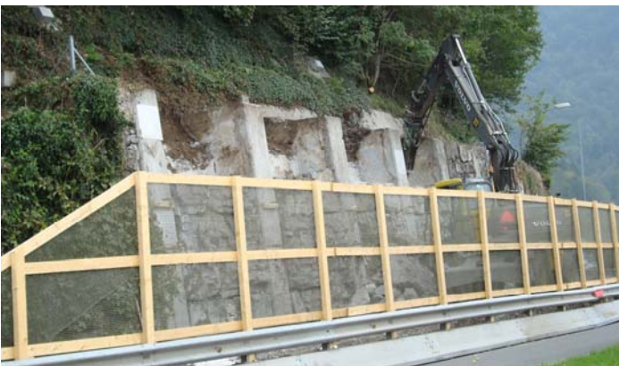
Rückbau von 2 einbetonierten Steinlagen
