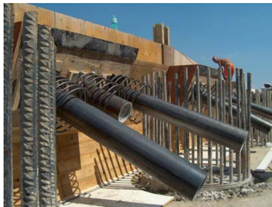
Stirnschalung Kopfriegel
