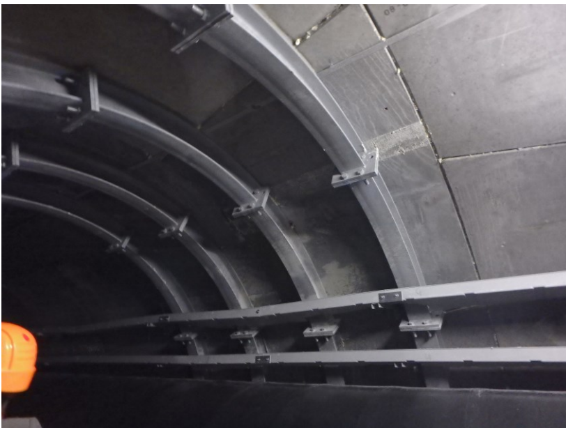
Sicherung von stark beschädigten Tübbingringen mit Stahlbögen.
