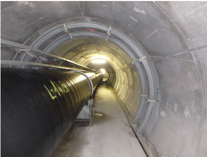
Stollen Sörenberg mit Gasleitung.
