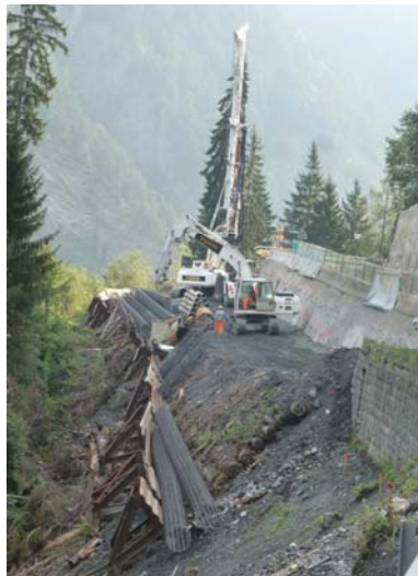
Erstellung Betonbohrpfähle
