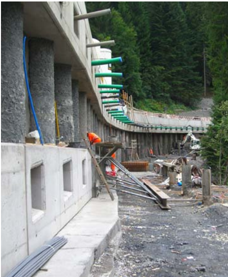
Betonarbeiten untere Longarine
