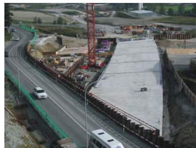
Bauvorgang Tagbaustrecke in Deckelbauweise
