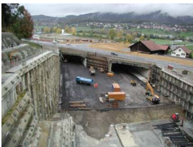
Bauvorgang Tagbaustrecke in Deckelbauweise
