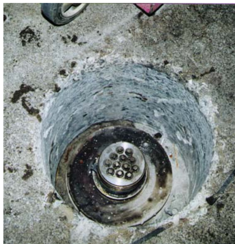
Neuer Ankerkopf im Längsträger
