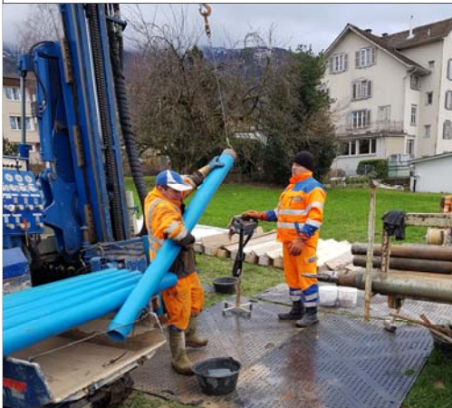
Einbau der Piezometerrohre ins Bohrloch.
