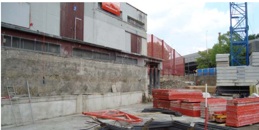
Unterfangung SZU Betriebsgebäude
