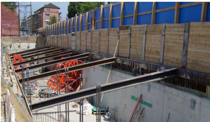
Spriessung der Rühlwand Seite Manessestrasse
