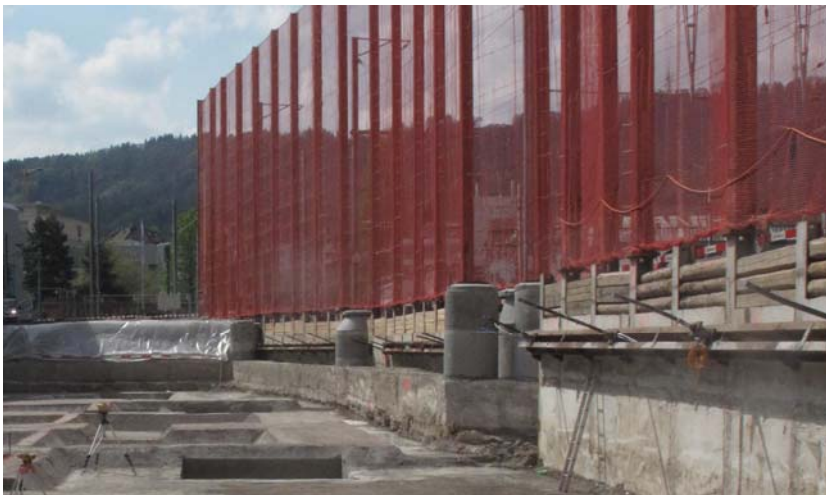
Blick in die Baugrube: Verankerte Rühlwand, Schutznetz zur SZU
