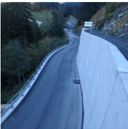
Blick von der fertiggestellten Wand- mauer in Richtung Tschiertschen
