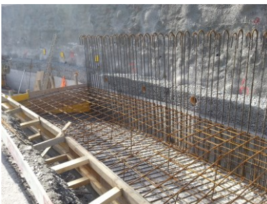
Bewehrung Mauerfuss und Anschlussbewehrung
