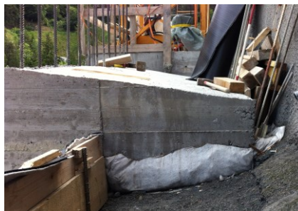
Detail Mauerkonsole (Erddruckabschirmung)
