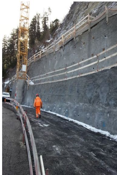
Bauhilfsmassnahmen: Nagelwand mit Zwischenberme
