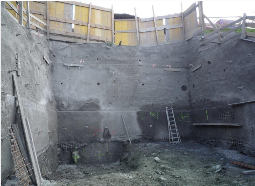
Nagelwand/Aushub in Ausführung
