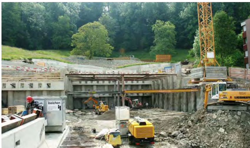
Hangsicherung mit verankerter Pfahlwand und mit verankerten Riegeln
