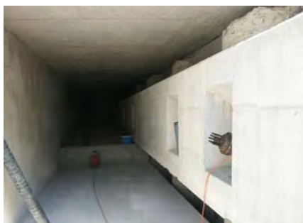
Hangsicherung mit verankerter Pfahlwand und mit verankerten Riegeln
