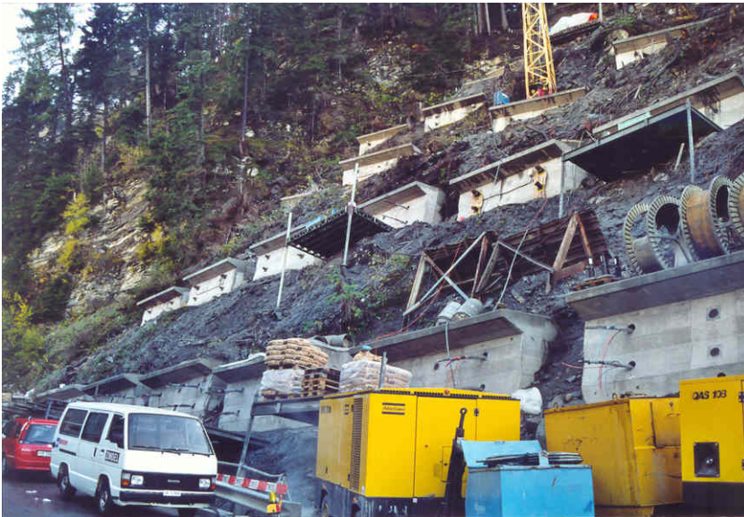
Hangsicherung: Betonwiderlager mit Verankerungen
