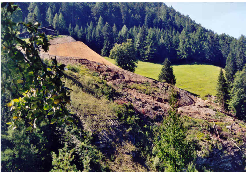
Hangabtrag: Abtragsgebiet, oben mit neu gestalteter Böschung
