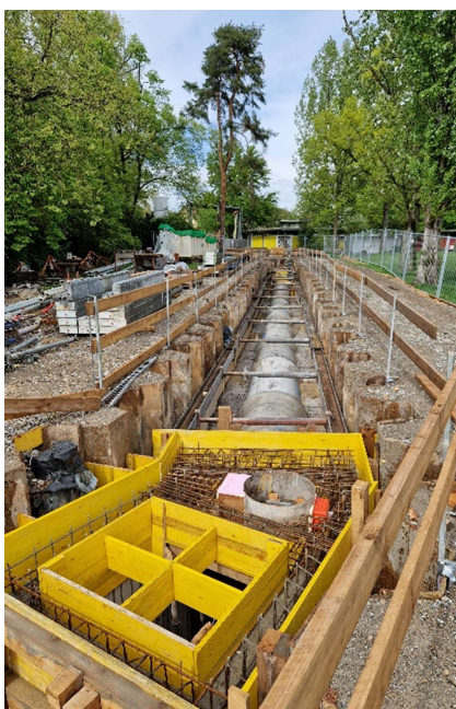
Links neuer Regenwasserkanal im Seebereich, rechts Grabenaushub in der Dufourstrasse.
