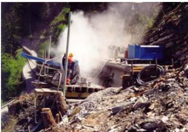
Ankerbohrung
