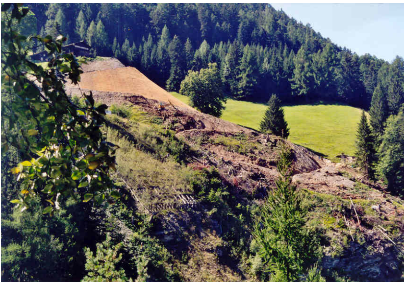
Hangabtrag: Abtragsgebiet, oben mit neu gestalteter Böschung
