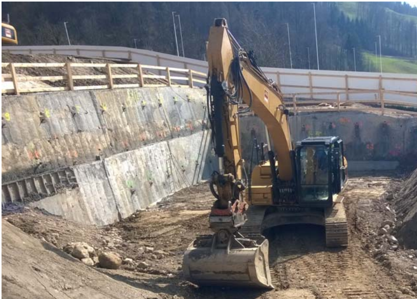
Nagelwand, Aushub 3. Etappe
