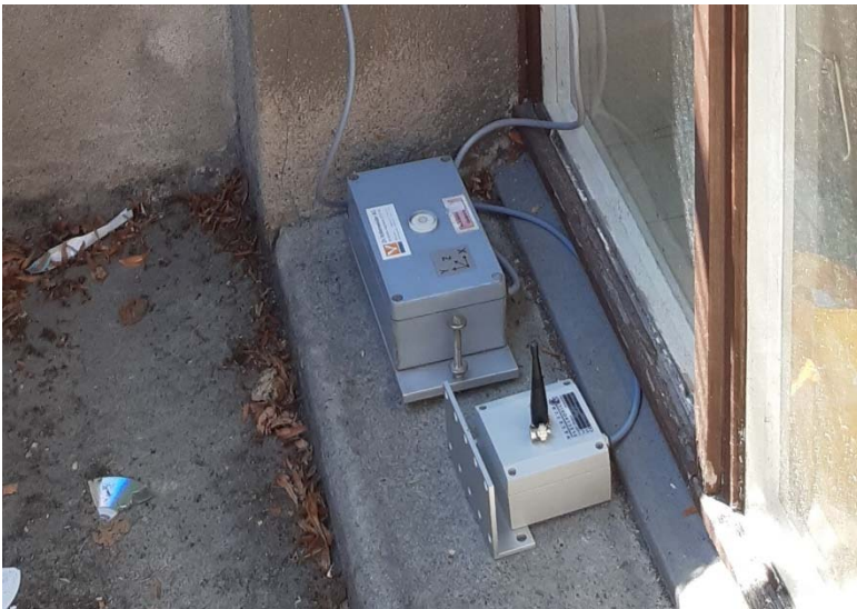
Geofon mit Funkantenne für die Übertragung der Erschütterungsmessungen zur Registriereinheit.
