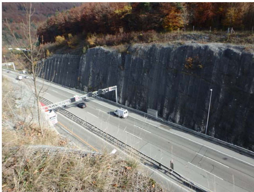
Stützbauwerk an der N2 im Abschnitt Belchen Süd-Härkingen: Felssicherung (Steinschlagvorhang, Nagelung, Betonplomben). Beurteilung: Gefährdungspotential 5, Schadenpotential 1, Risiko gross, Empfehlung Detailanalyse
