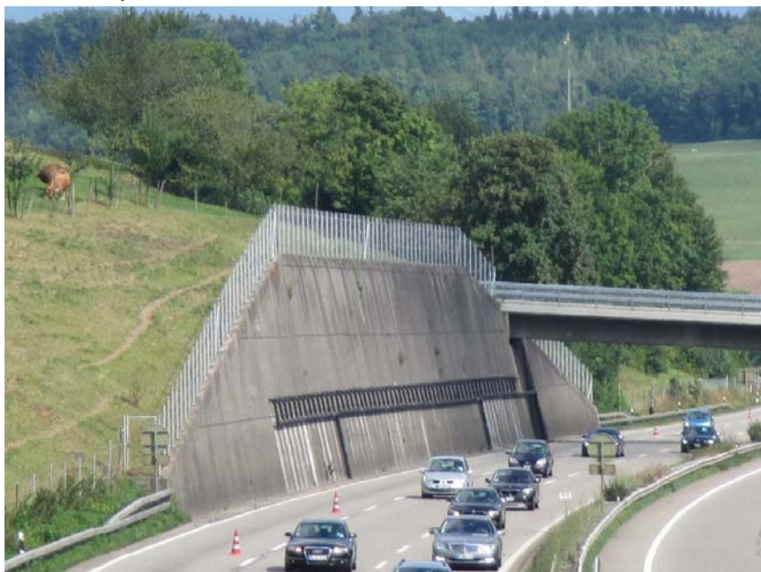
Stützbauwerk an der N2 im Abschnitt Belchen Süd-Härkingen: Felssicherung (Steinschlagvorhang, Nagelung, Betonplomben). Beurteilung: Gefährdungspotential 5, Schadenpotential 1, Risiko gross, Empfehlung Detailanalyse
