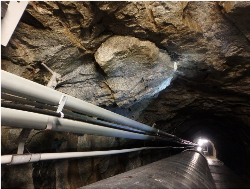
Stollen Grimsel mit potentiellm Bruchkörper über der Gasleitung. Als Sicherungsmassnahme wurde eine Verankerung mit ungespannten Felsankern empfohlen.
