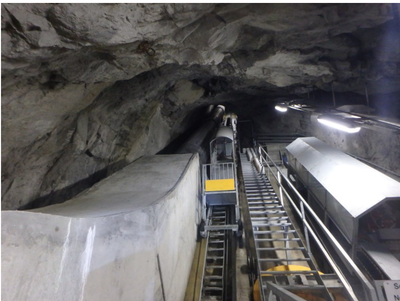
Schrägschacht mit Stollenbahn im Stollen Gries.
