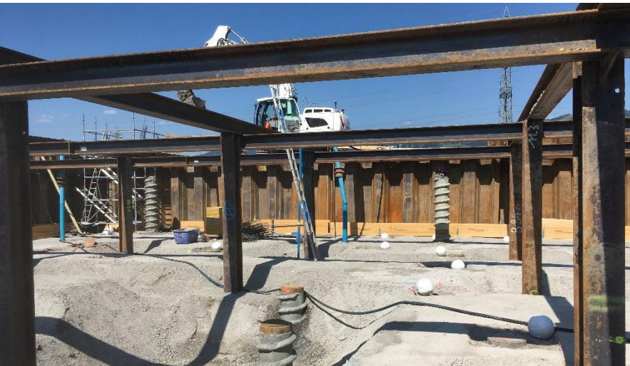
Baugrube im Endaushub
