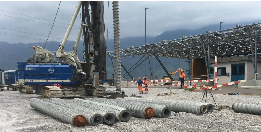
Eindrehen der Schraubenpfähle ab OK Terrain
