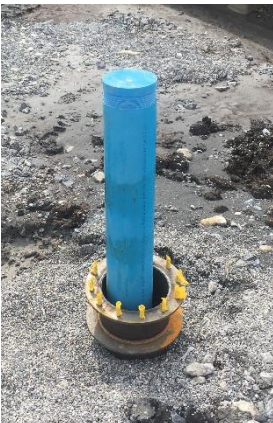
Links: Grundwasserstutzen um frisch erstellten Kleinfilterbrunnen
