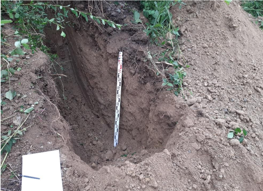
Baggerschlit in der unterwasserseitigen Dammböschung. Das locker gelagerte, stark sandige Dammschüttmaterial kommt zum Vorschein. Zur Beurteilung der hydraulischen Durchlässigkeit wurden Materialproben entnommen und im Erdbaulabor die Kornverteilung bestimmt.
