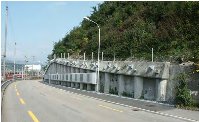
Instandgesetzte Pfahlwand mit neuer Longarine
