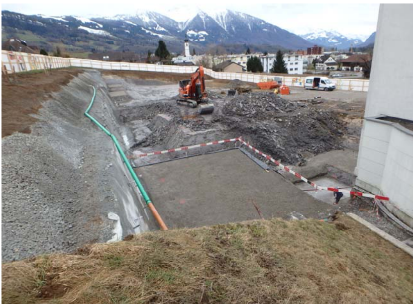
Blick in die Baugrube mit beträchtlichem Hanganschnitt. Zur geomesstechnischen Überwachung wurden total 4 Inklinometermessstellen auf der Hangseite der Baugrube eingebaut.
