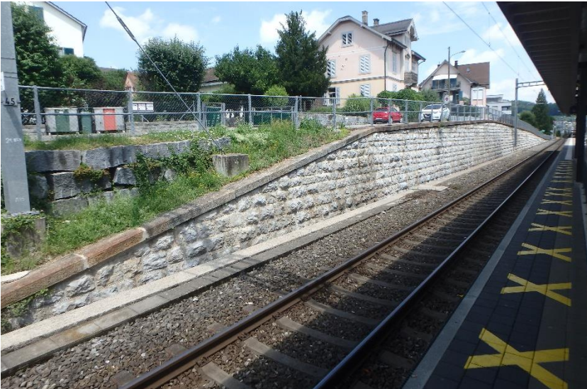
Stützbauwerk Affoltern am Albis und das Gleis 3 des Bahnhofs Affoltern am Albis (Blickrichtung Zürich). Das als kombiniertes Natur-Betonmauerwerk ausgeführte Bauwerk sichert den Geländesprung zwischen der Alten Obfelderstrasse und dem Gleis 3. Vom Bauwerk sind die Kalksteine des Mauermantels, die Gneisquader der Mauerkrone und die feuerverzinkte Stahl-Absturzsicherung zu sehen.
