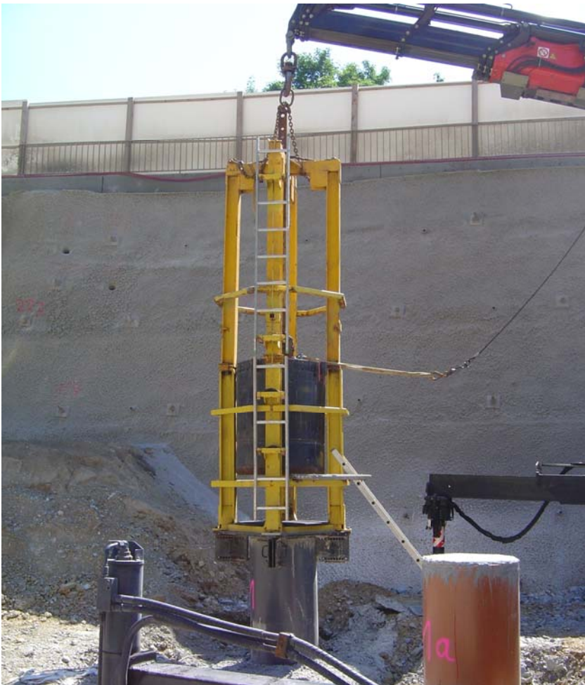
Einrichtung zur PDA-Prüfung mit 7.9 t schwerem Fallgewicht
