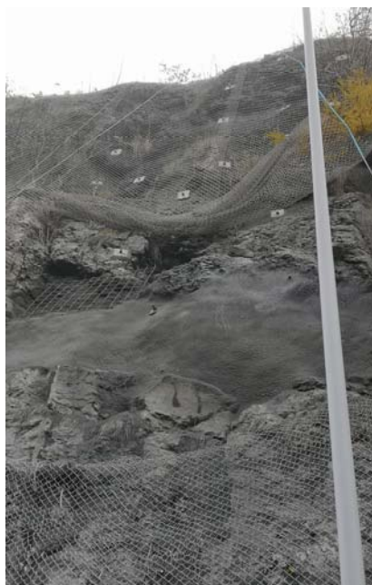
Felssicherung mit Felsabtrag, Spritzbetonplomben und Handnägeln am Bauwerk Balm Ost Hägendorf. Leichter Felsabtrag im Gang (linkes Bild). Felssicherung mit Spritzbetonplombe und Handnägeln (rechtes Bild).
