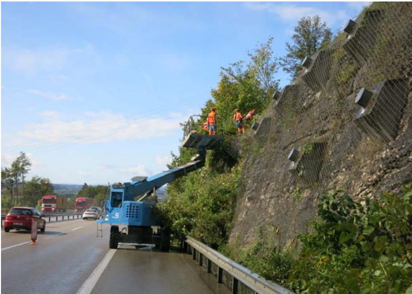
Rodungsarbeiten ab Hebebühne und am Seil für Bauwerk Eggberg 01. Anschliessend Netzleerung, Reparatur und Ergänzung des liegenden Steinschlagschutznetzes. An den Vorspannankern wurden visuelle Kontrollen und Abhebekraftkontrollen durchgeführt.
