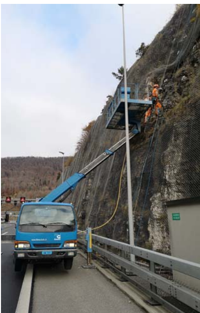
Felssicherung mit Felsabtrag, Spritzbetonplomben und Handnägeln am Bauwerk Balm Ost Hägendorf. Leichter Felsabtrag im Gang (linkes Bild). Felssicherung mit Spritzbetonplombe und Handnägeln (rechtes Bild).
