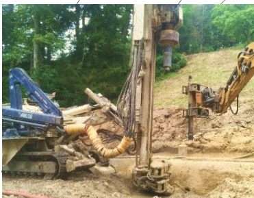
Situation mit Massnahmen Hangsicherung. Rechts oben: Bild Grabenaushub in steilem Gelände, links unten: Bild Erstellung Mikropfähle.
