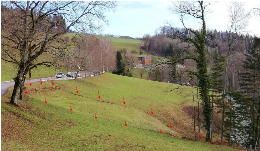
Blickrichtung Nordosten auf den oberen Hangbereich vor Massnahmen. Die Anrisskante der Rutschung ist deutlich erkennbar.
