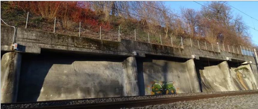
Bestehende nach Niederbruch verstärkte Stützkonstruktion (Typ B) mit Ort-betonstützen und bergseitig auskragendem Kopfriegel
