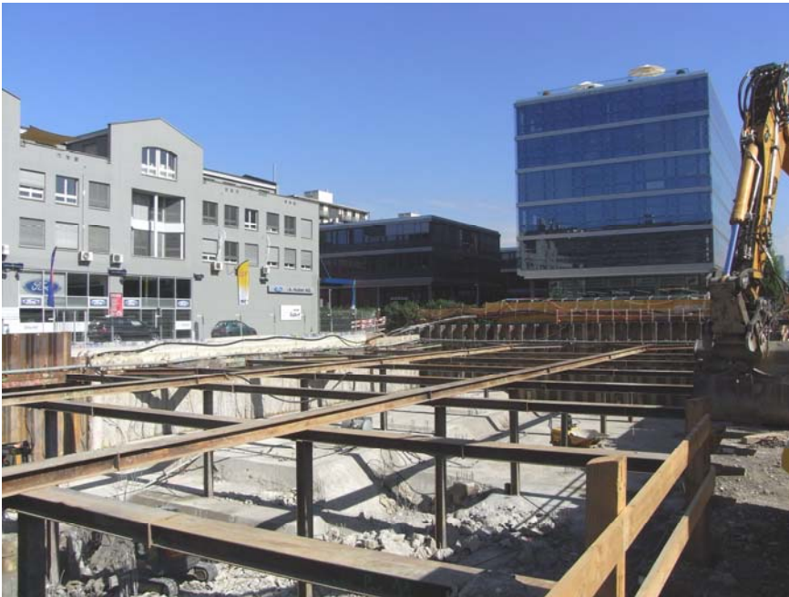
Übersicht Baugrube, Endaushub erstellt.
