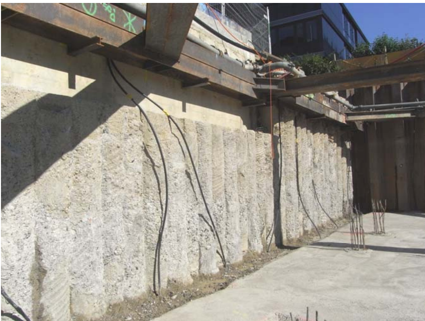
Überschnittene Bohrpfahlwand \varnothing 60 cm als Baugrubenabschluss und definitive UG-Wand, direkt anschliessend an das Untergeschoss eines bestehenden Gebäudes.
