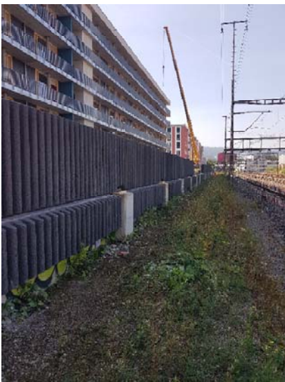
Linkes Bild: Fertig erstellte Lärmschutzwand. Im Hintergrund Pneukran zum Versetzen der Lärmschutzelemente. Rechts die SBB-Gleise und die 16 m hohe Übertragungsleitung.
