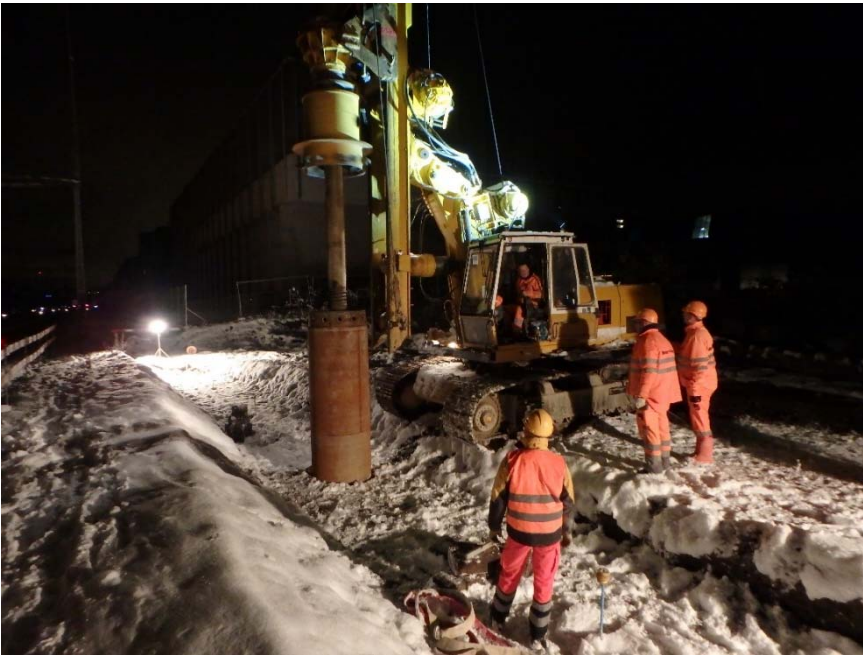
Erstellung Bohrpfähle in Nachtarbeit. Schneckenortbetonpfahl (SOB) Ø 800 mm
