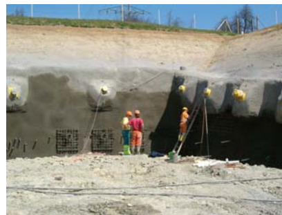
Spritzbetonsicherung
