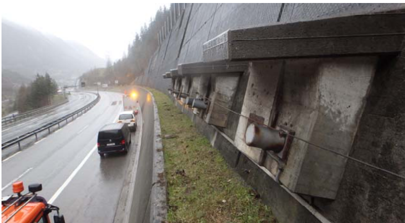
Verankerung der Stützmauer entlang der Fahrbahn N2. Ankerwiderlager, Schutzdächer und Schutzhauben der Anker.
