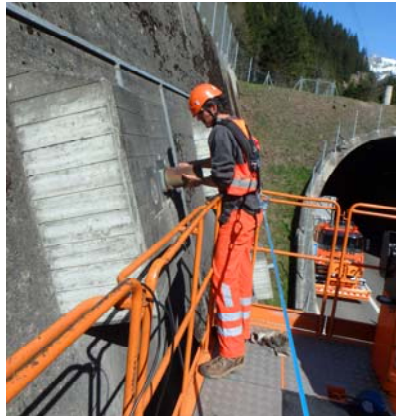
Öffnen einer Schutzhaube von einer LKW-Hebebühne aus
