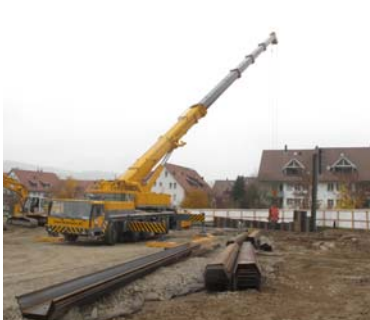
Einbringen der Spundwandbohlen
