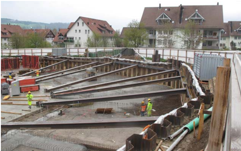
Blick in die Baugrube: Spundwand, auf Bodenplatte gespiesst
