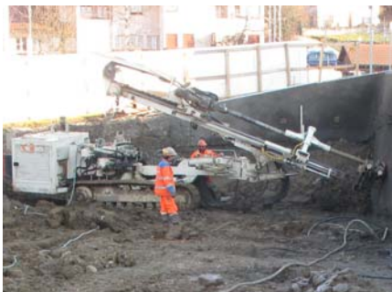
Bohren der ungespannten Anker (Nägel)
