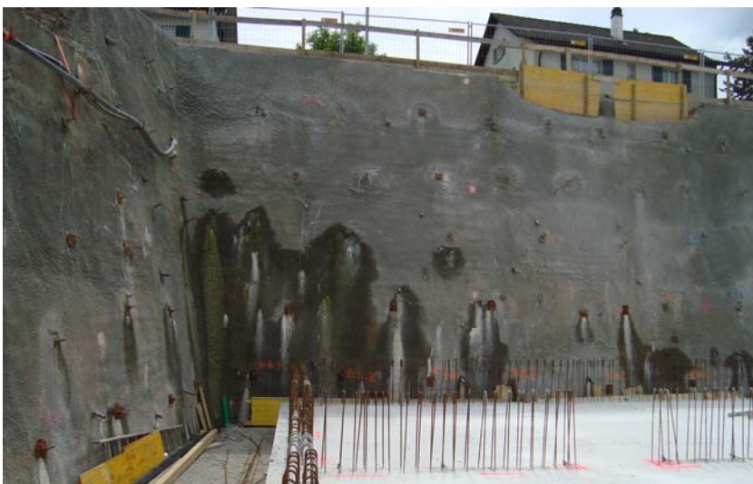
Nagelwand im südlichen Teil der Baugrube
